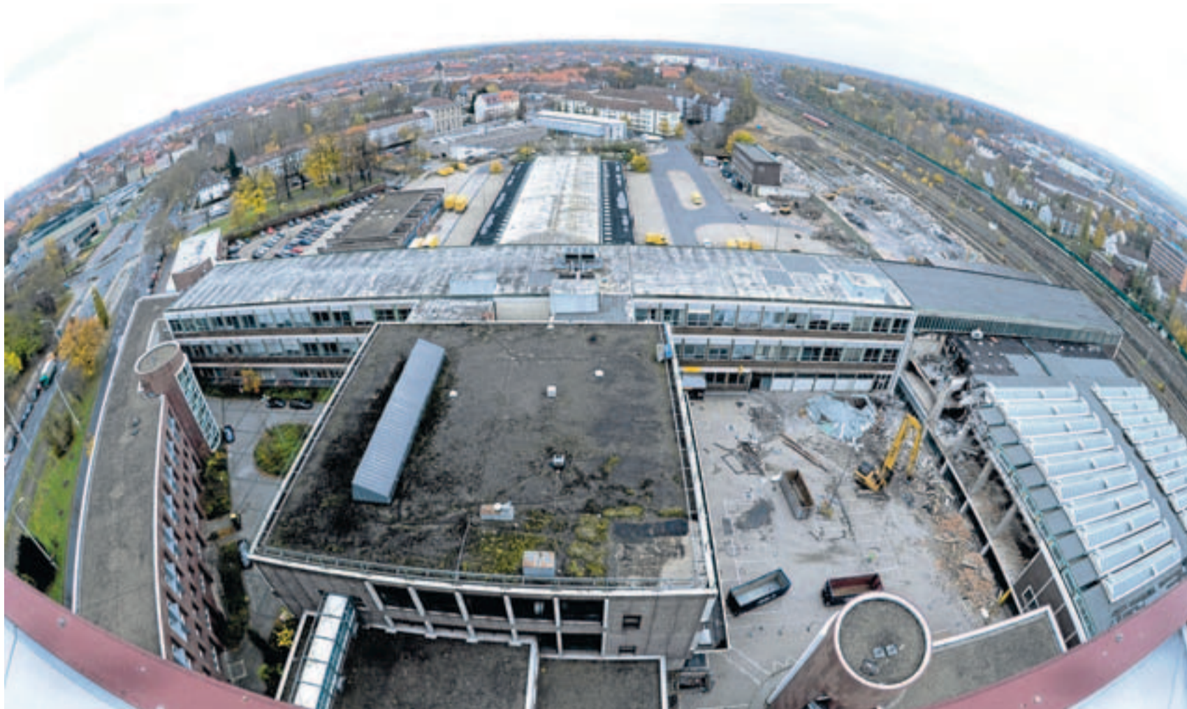
Blick aus 60 Metern Höhe von der „Toblerone“ auf das alte Postareal: Im Frühjahr wird es nahezu komplett geräumt sein. Der Paketbahnhof (hinten rechts) ist bereits verschwunden. An seiner Stelle soll das Fachmarktzentrum entstehen. Zurzeit wird die alte Packhalle (vorn rechts) abgerissen. Foto: Rudolf Flentje
