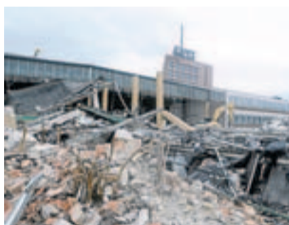
Der alte Paket-Bahnhof ist nur noch Schutt. Hinten die Toblerone, die als einziges Gebäude des alten Postareals erhalten bleibt. Foto: Flentje
